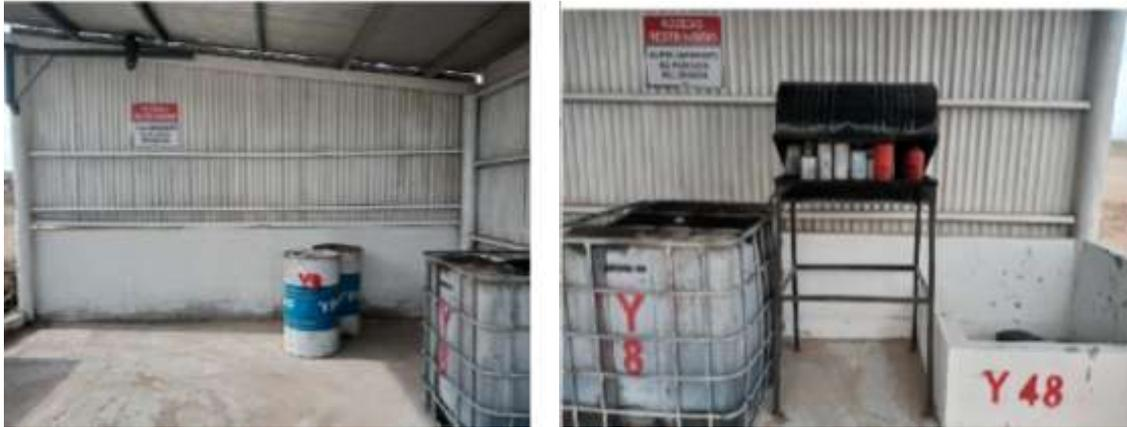
Figura V 63, Depósito de residuos peligrosos con contenedores aptos para cada tipo.
