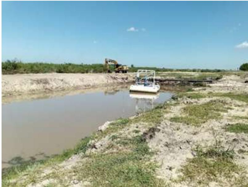
Figura V 31. Toma de agua en la pileta de recirculación.
