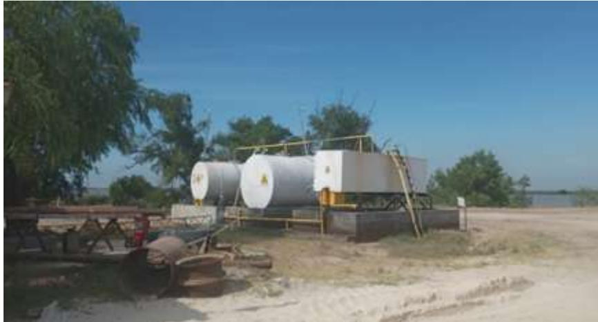
Figura V 75. Tanques de combustible con pileta antiderrame.
